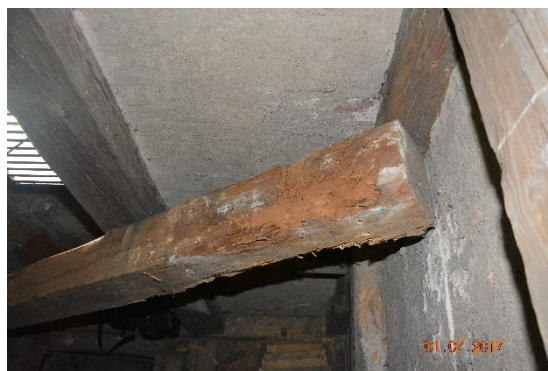
(widok zerwanej belki stropowej)
