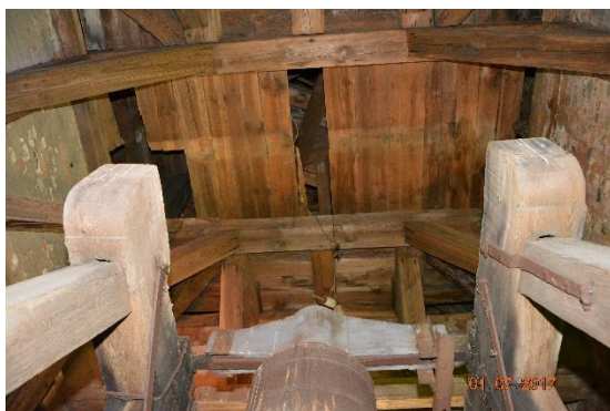
(widok na strop z brakującą belką stropową)
